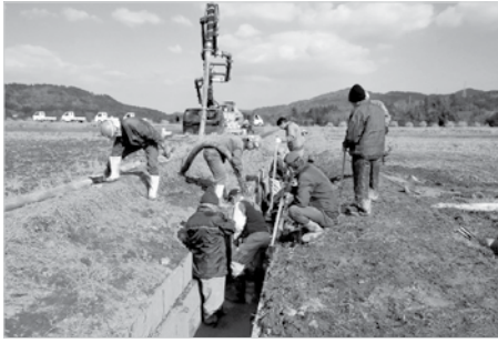
排水路のコンクリート化
